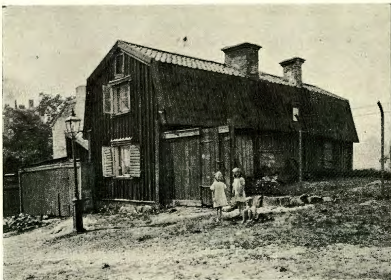
Huset med skomakarverkstaden Högbergsgatan 4. (Foto: Stockholms stadsmuseum).
