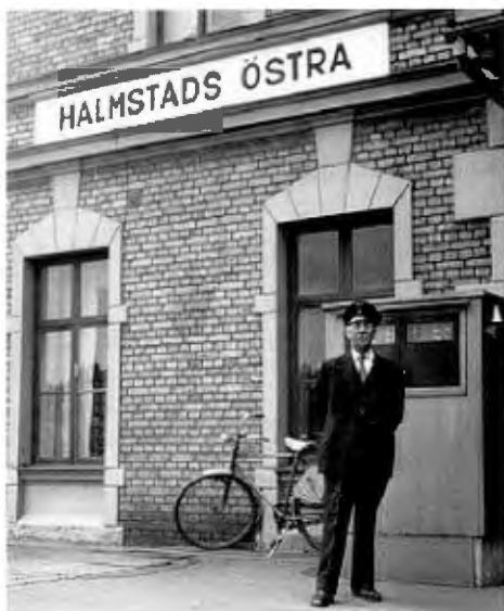
Stationskarl Filip Nilsson vid ställverket på stationen i Halmstad.
